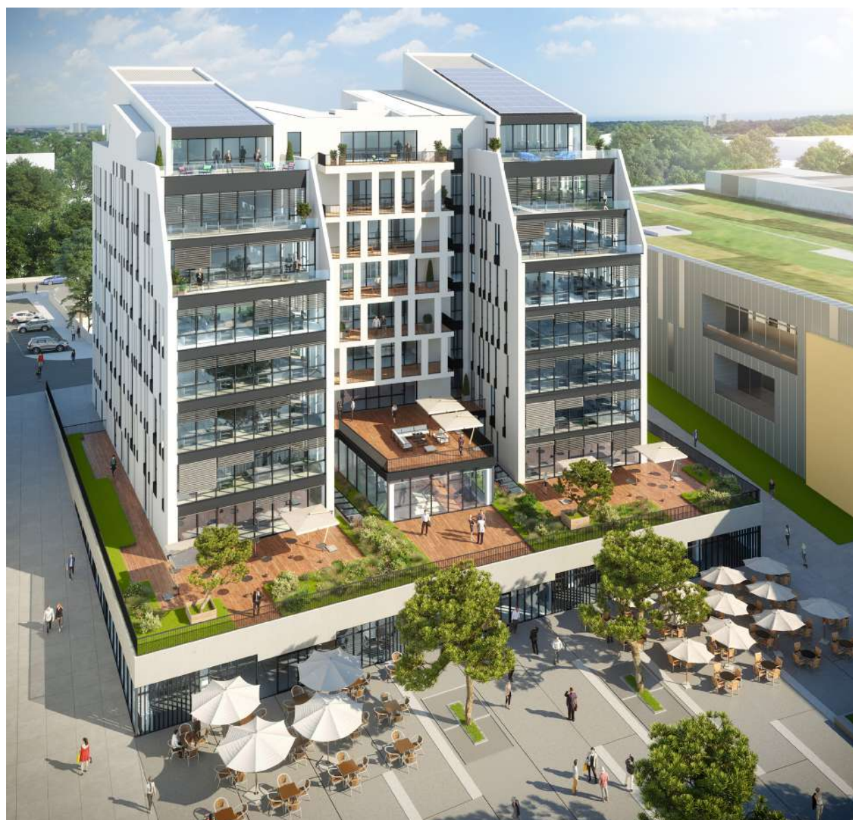
La Façade Sud, directement connectée à la place publique
